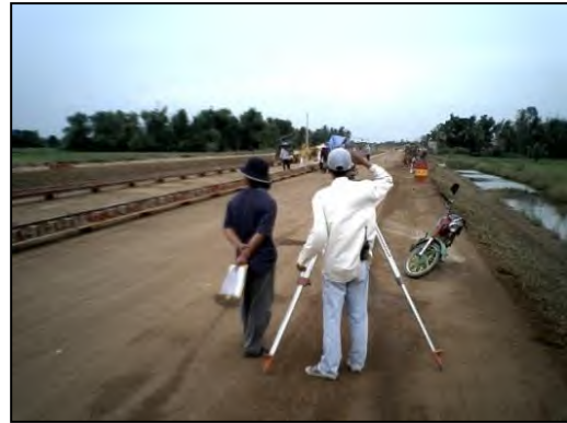
งานตรวจสอบระดับแบบหล่อ
