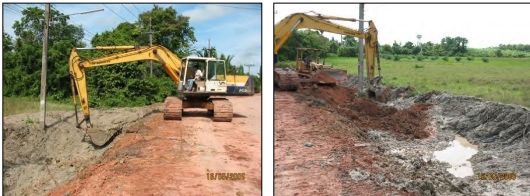
รูปที่ ๒-๒๕ งานขุดวัสดุไม่เหมาะสม
