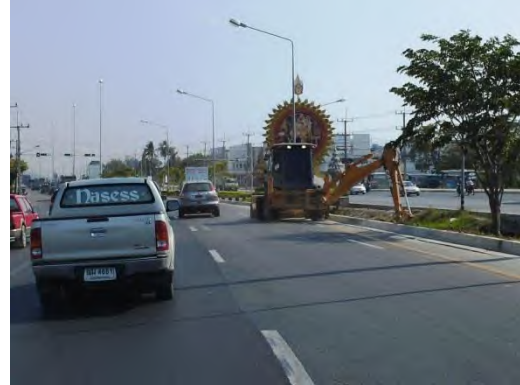
ก) ปฏิบัติงานใต้ไหล่เขา ที่เสี่ยงต่อการโคตถล่มทับ ข) ทำงานโดยไม่มีเครื่องกัน และสัญญาณเตือน รูปที่ ๕-๕ เครื่องจักรอยู่ในพื้นที่ไม่ปลอดภัย
