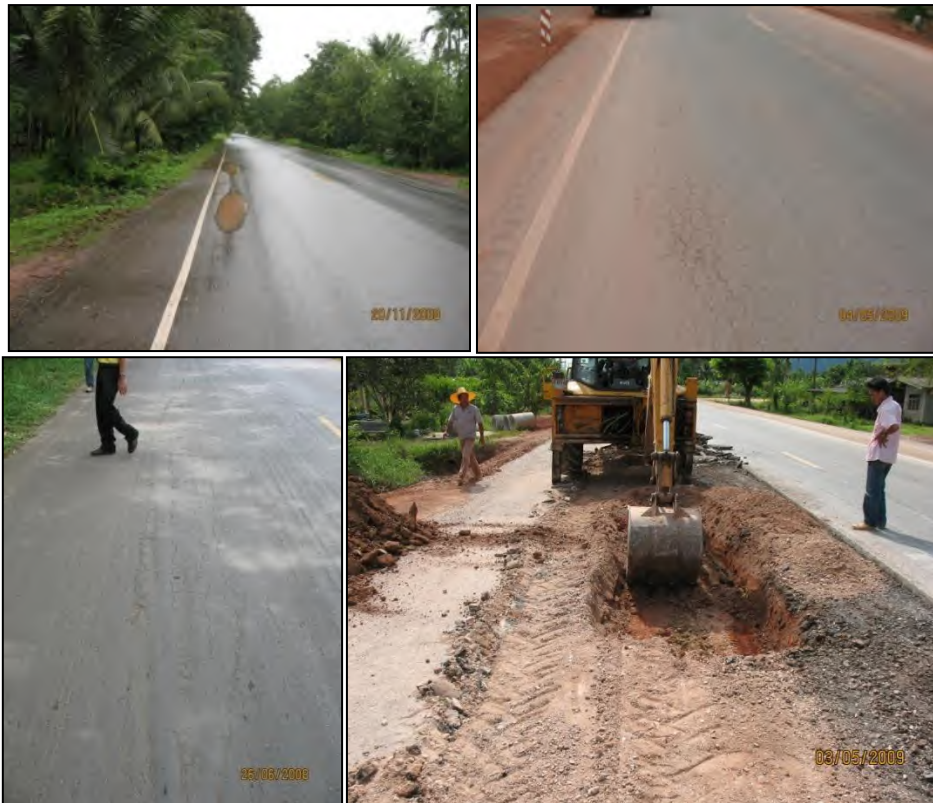
รูปที่ ๒-๒๖ งานขุดบริเวณดินอ่อน
