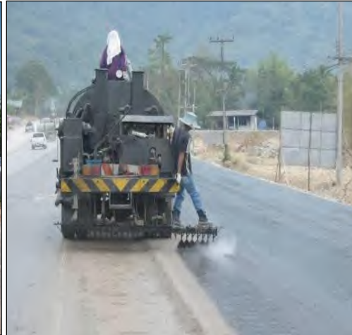
รูปที่ ๒-๓๕ แสดงงานลาดแอสฟัลท์ Prime Coat
