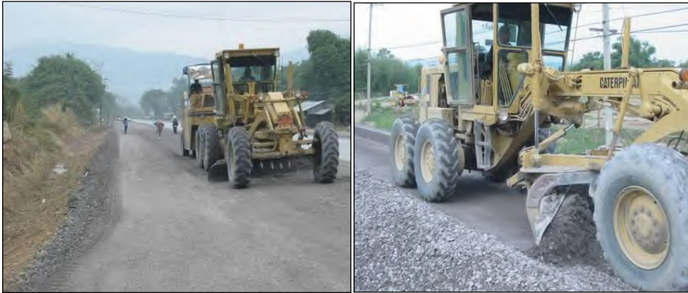
รูปที่ ๒-๓๒ เครื่องจักรกลในงานพื้นทางหินคลุก
