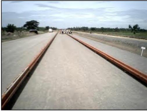
ติดตั้งแบบหล่อ
