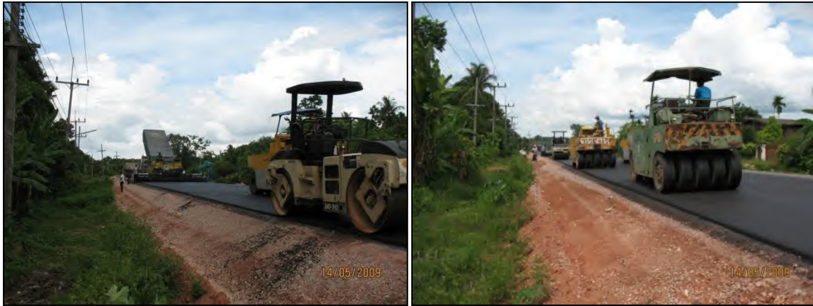
รูปที่ ๒-๓๗ งานแอสฟัลท์คอนกรีต
