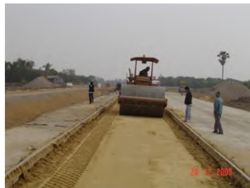
งานเกลี่ยทรายและบดทับ
