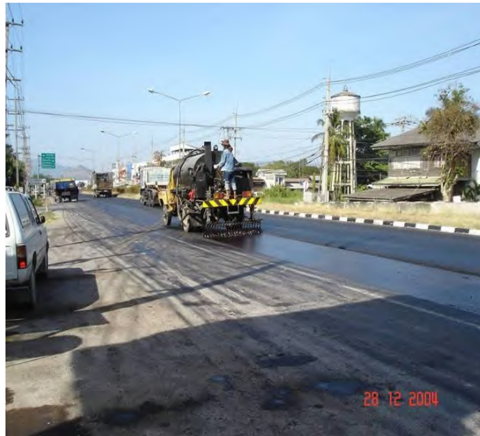
รูปที่ ๒-๓๖ งานลาดแอสฟัลท์ Tack Coat
