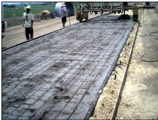
งานเทคอนกรีต
