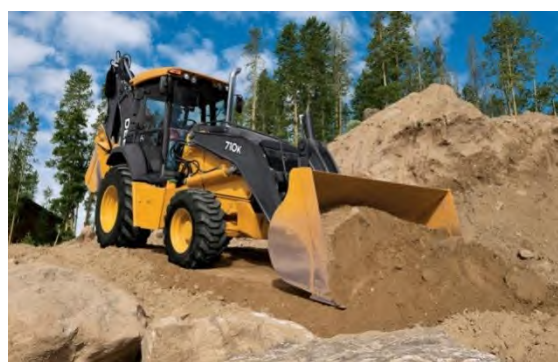
รูปที่ ๓-๘๖ ใช้ล้มกองวัสดุและปรับพื้นที่ (Grader)
