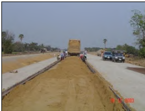
งานทรายรองใต้ผิวทางคอนกรีต
