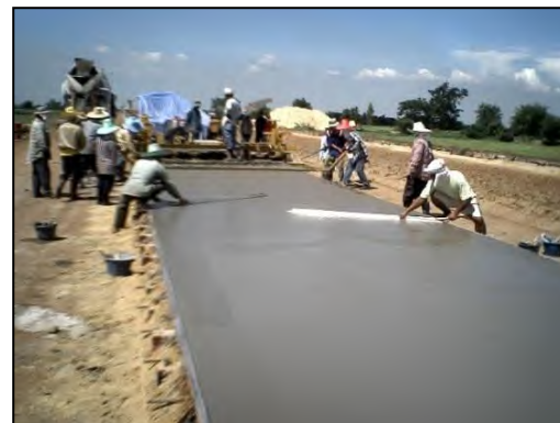
งานปาดแต่งผิวคอนกรีต
